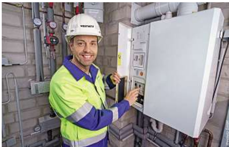
Die Monteure – hier bei der Arbeit vor einer Erdgastherme – werden in den Siegerländer Kommunen auf H-Gas umstellen.
